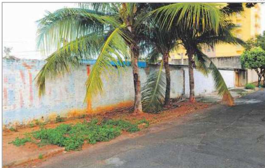
Na rua Frei Luiz Santana, em frente ao número 75, na Vila Independência, vegetação prejudica uso da calçada
